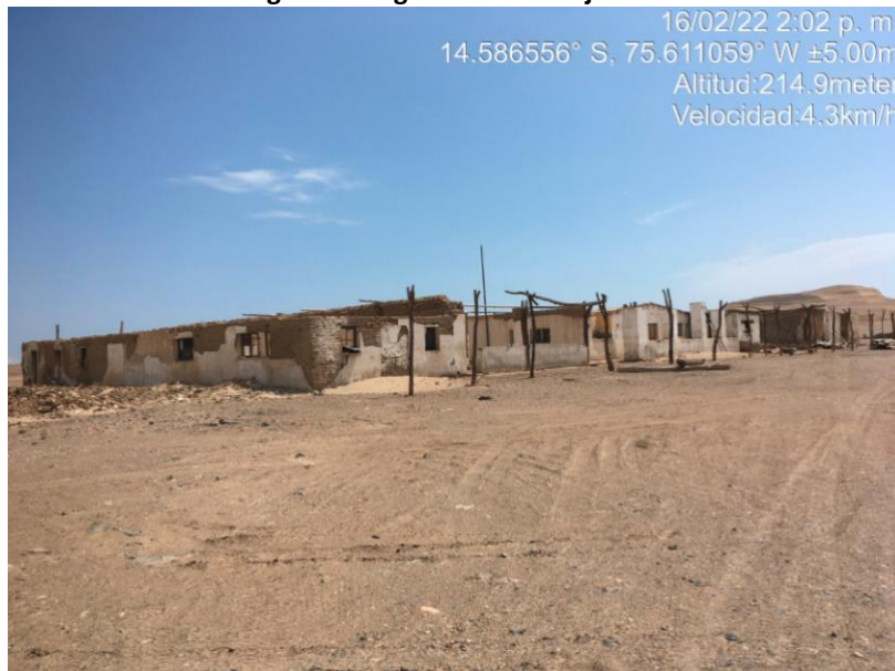
Fotografía 1 Lugar "Fundo Ullujalla"
